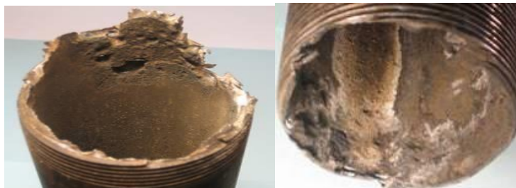
а – коррозионный износ; б – коррозионные осадки
