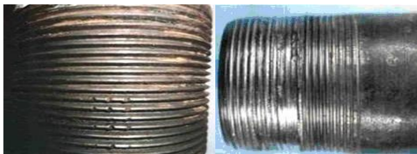
а – забоины на поверхности резьбы; б – витки резьбы с поверхностью
